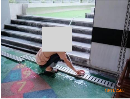
ภาพที่ 2.2-52 การทำความสะอาดรางระบายน้ำ
