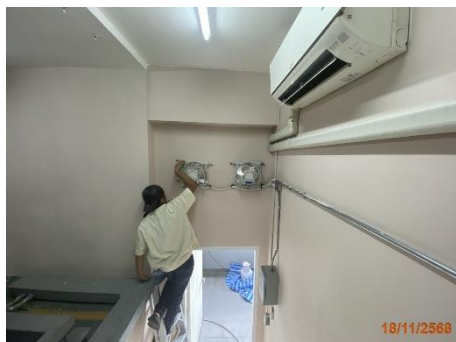
ภาพที่ 2.2-69 การตรวจสอบระบบระบายอากาศ
