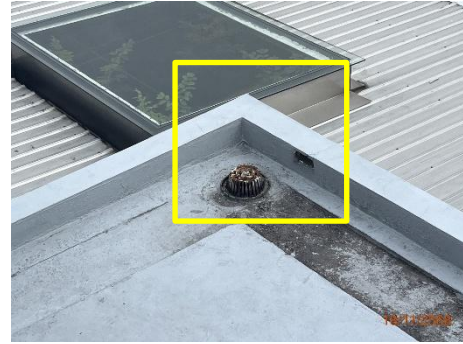
ภาพที่ 2.2-53 การใช้ตะแกรงครอบรูท่อระบายน้ำ
