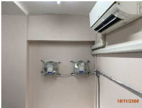
ภาพที่ 2.2-46 อุปกรณ์ระบายอากาศ
