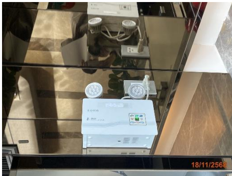
ภาพที่ 2.2-35 ระบบไฟส่องสว่างฉุกเฉิน
